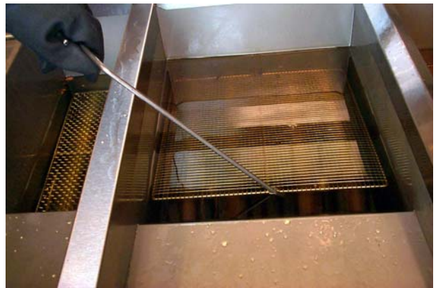
Filtreleme öncesi kızartma kabından destek levhasının çıkarılması.
